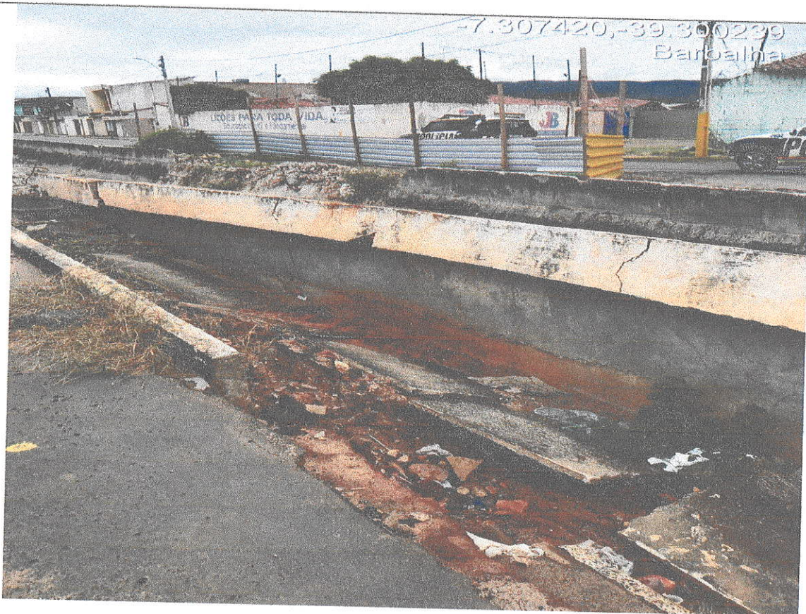
12 e 13- Parede deslocada e destruída, asfalto e calçadas destruídas
