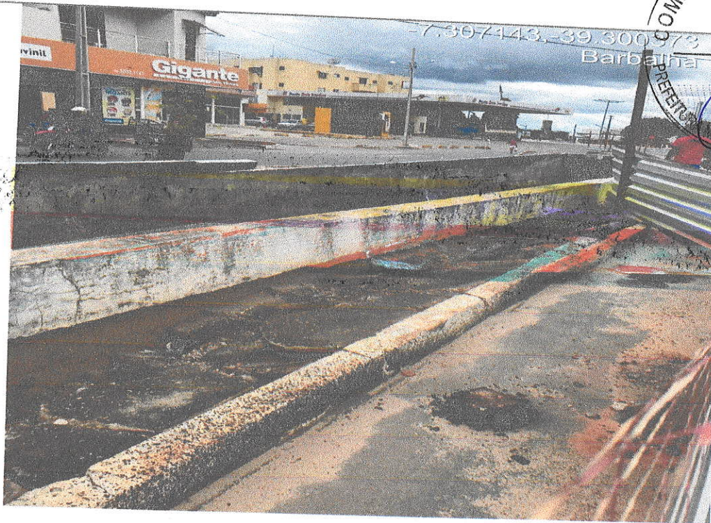
12 e 13- Parede deslocada e destruída, asfalto e calçadas destruídas
