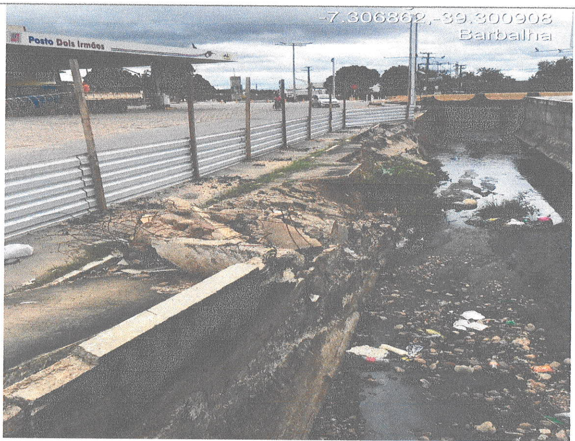
18 e 19 – Calçadas e paredes destruídas.
