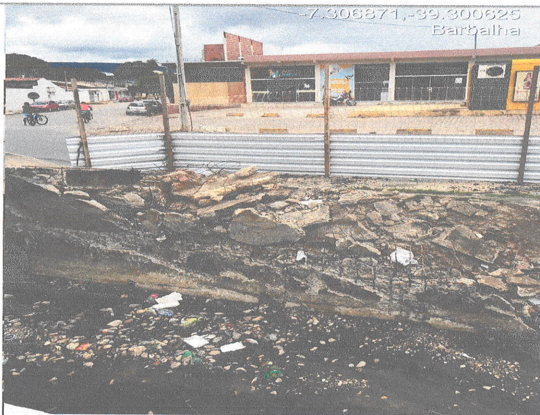
14 e 15 - Parede deslocada e destruída, asfalto e calçadas destruídas
