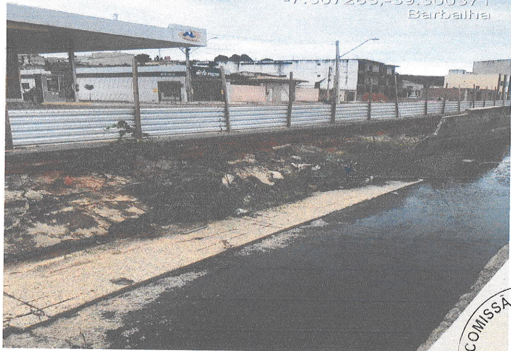
06- Asfalto levantado e destruído / 07- Parede e calçada lateral destruídas.
