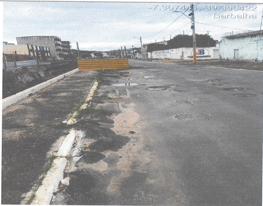
04 e 05- Parede e calçada destruídas, drenagem entupida.
