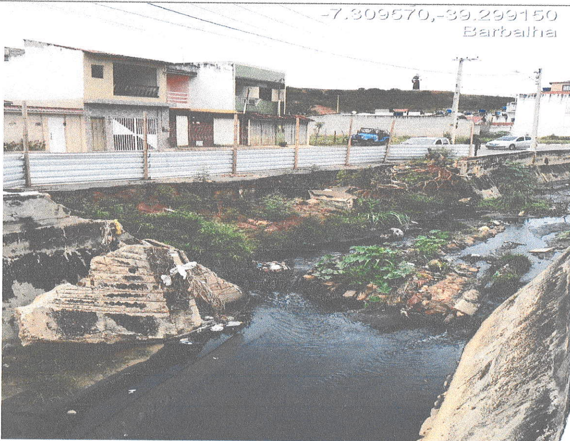
20 e 21 – Paredes, calçadas e asfalto destruídos.
