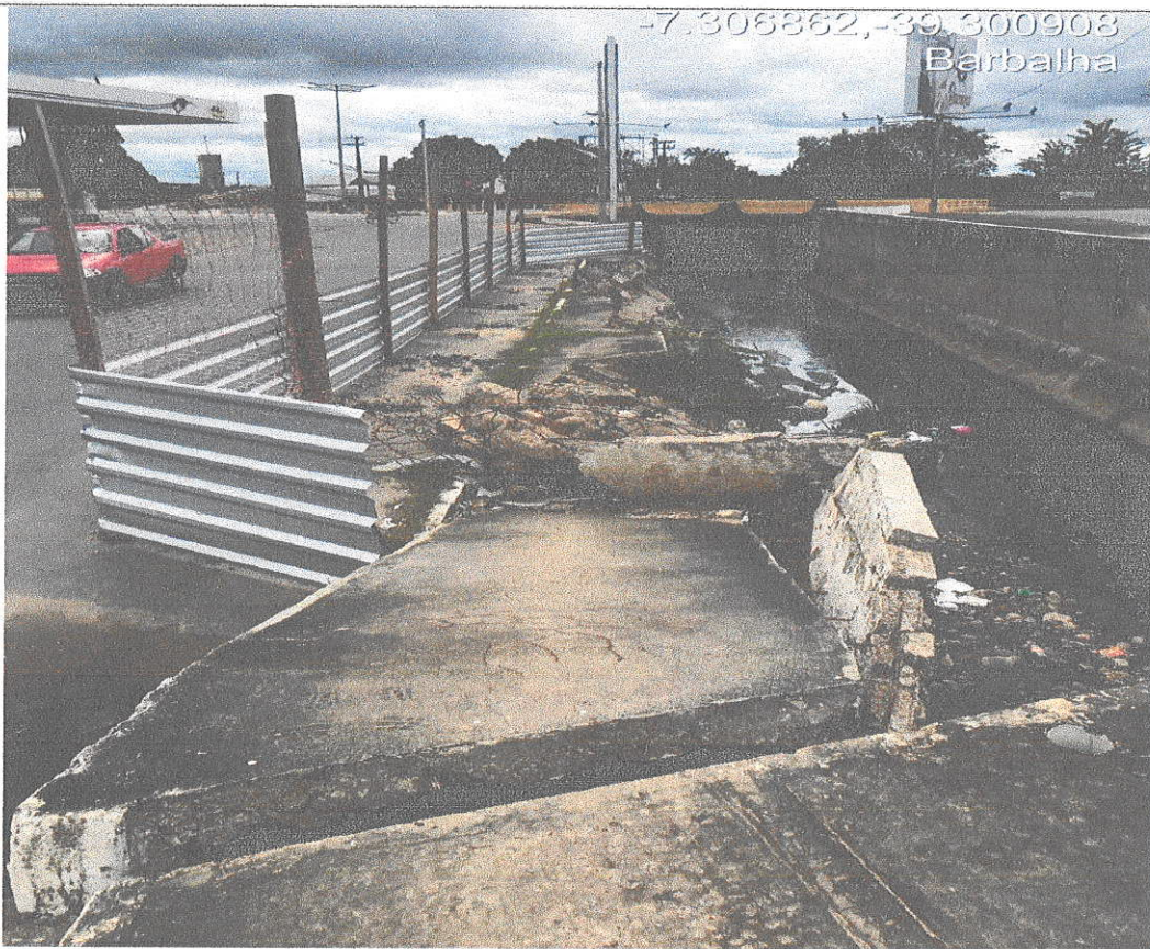
16 – Parede destruída. / 17- Paredes com grandes rachaduras.
