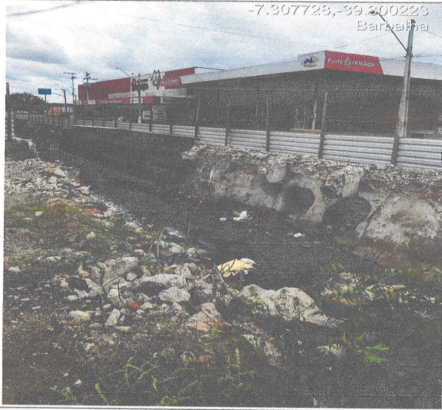
04 e 05- Parede e calçada destruídas, drenagem entupida.
