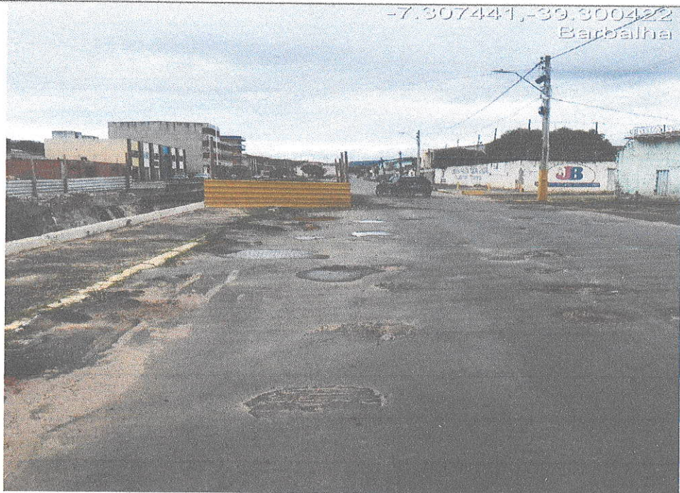
02- Parede e calçada destruídas, drenagem entupida. / 03- Asfalto levantado e destruído.
