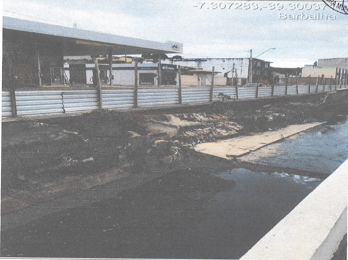
06- Asfalto levantado e destruído / 07- Parede e calçada lateral destruídas.
