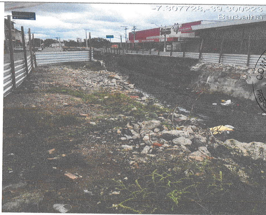
08 e 09- Parede e calçada destruídas, drenagem entupida.
