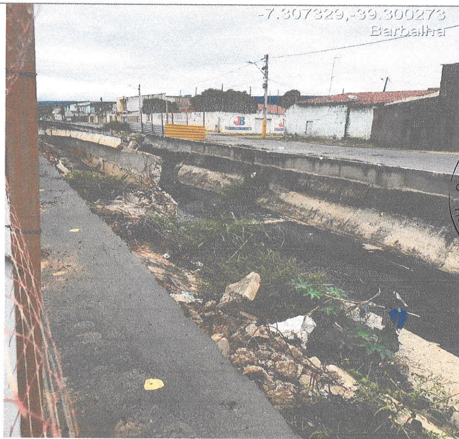
14 e 15 - Parede deslocada e destruída, asfalto e calçadas destruídas
