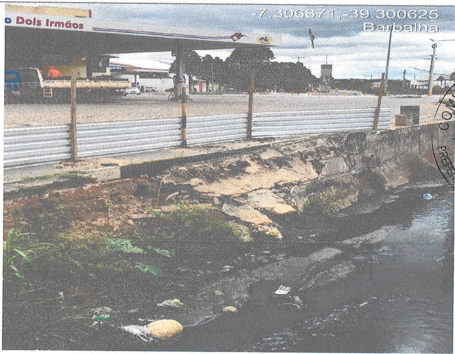
18 e 19 – Calçadas e paredes destruídas.
