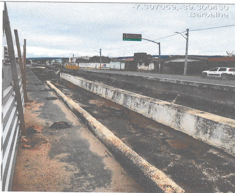
08 e 09- Parede e calçada destruídas, drenagem entupida.
