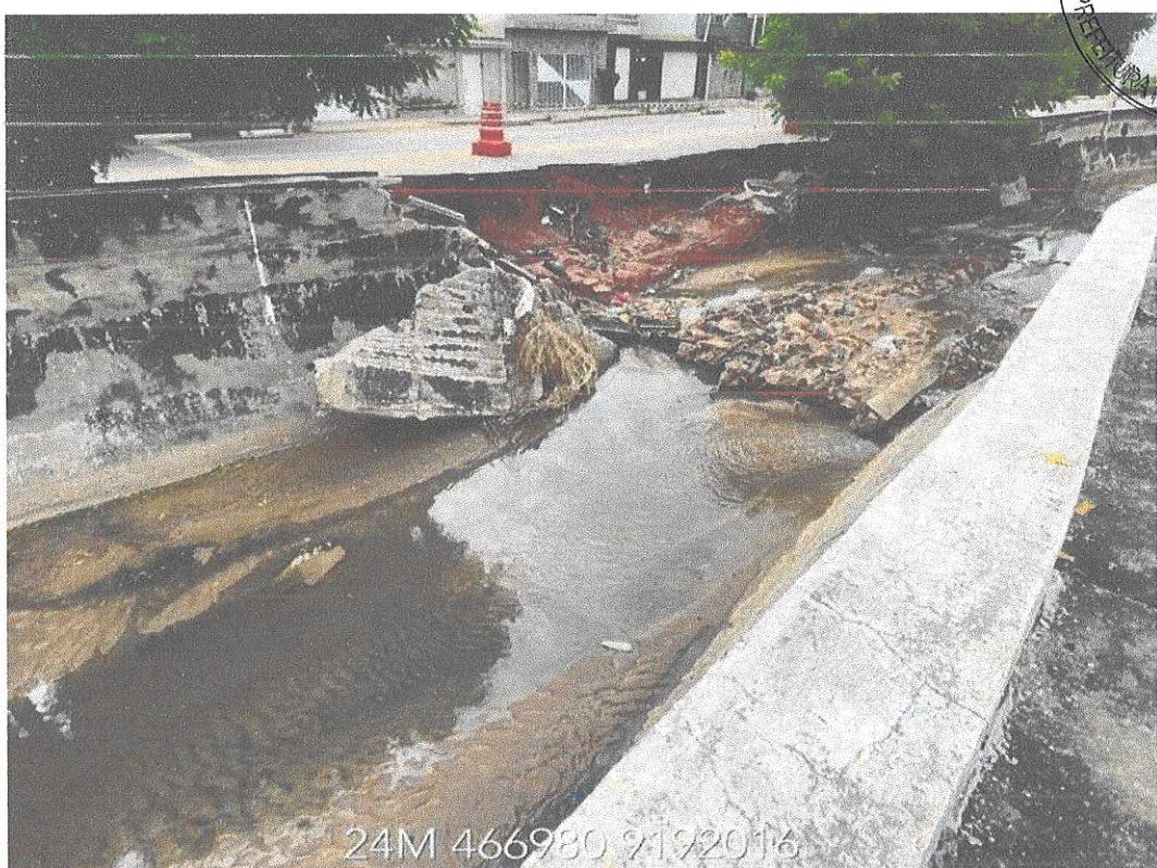
Parede do canal que desabou com a energia da água. DATA: 13/04/2022
