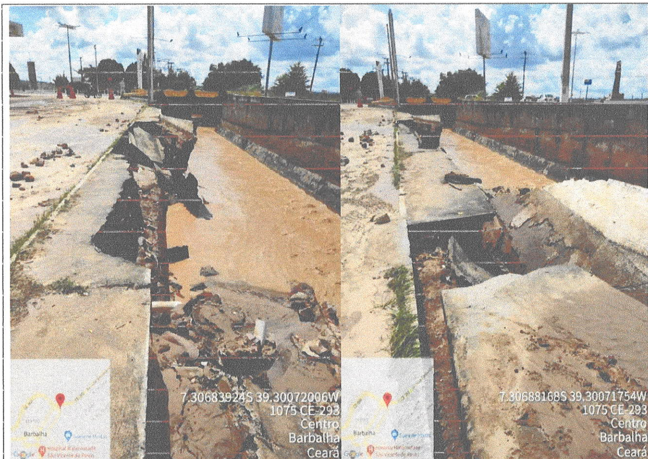
Parede do canal que desabou com a energia da água. DATA: 13/04/2022
