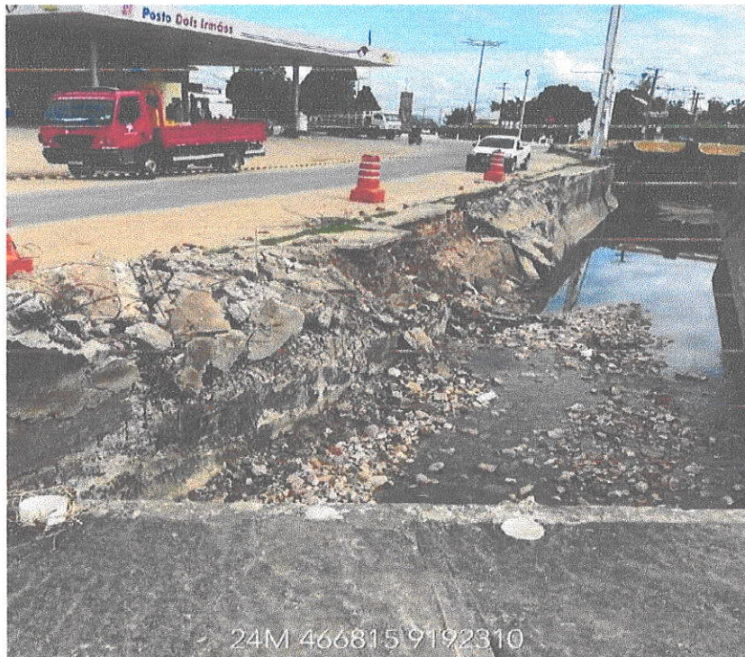
Parede do canal que desabou com a energia da água. DATA: 13/04/2022
