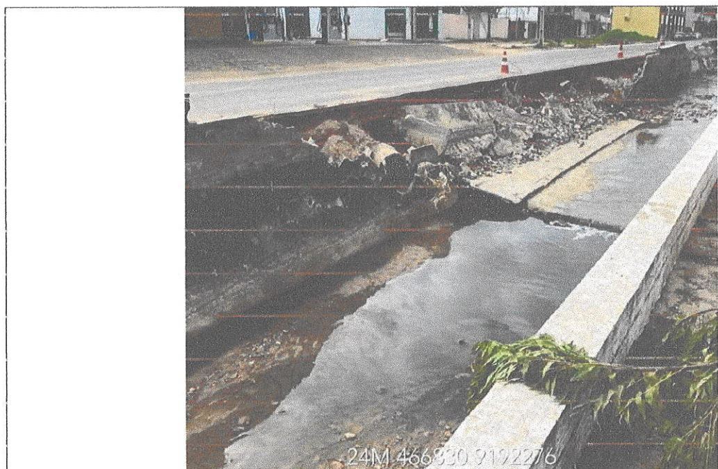
Parede do canal que desabou com a energia da água, a qual também carregou parte do aterro da via. DATA: 13/04/2022
